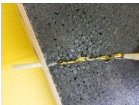
15. GFK-Stab nicht ganz einschieben und Leimspur auftragen
