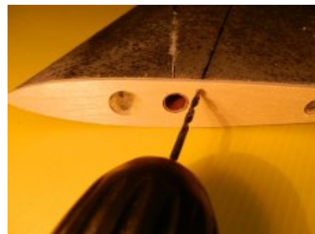
14. Mit 3.2 mm Bohrer Zugang für den GFK-Stab bohren
